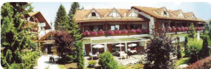
Die baulich sehr ansprechende Einrichtung in Kiefersfelden
